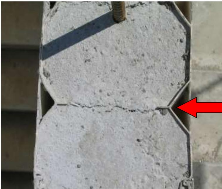
**CRACK CONTROL JOINTS
