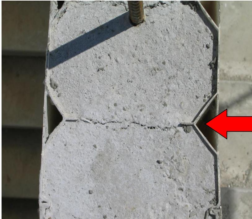
**CRACK CONTROL JOINTS
